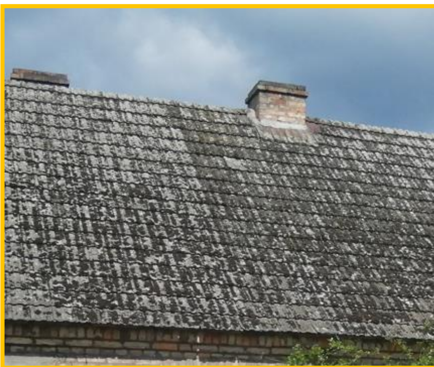
Rysunek 7 Przykłady budynków pokrytych płytami azbestowo-cementowymi w Drawsku
