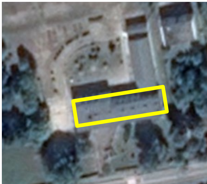
Rysunek nr 19. Możliwość montażu instalacji fotowoltaicznej na dachu budynku Szkoły Podstawowej w Drawskim Młynie, ul. Szosa Dworcowa 2, Źródło: http://mapy.geoportal.gov.pl
